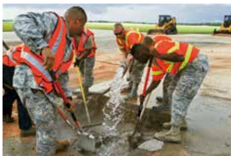
アンダーセン空軍基地において、超速硬性コンクリートを用いた最新の滑走路被害復旧法を演練する空軍第38土木作業隊隊員（2014年1月23日）（U.S. Air Force photo/Airman 1st Class Emily A. Bradley）
