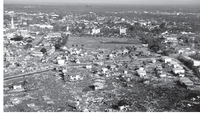
津波で破壊されたインドネシア・スマトラ島沿岸部 (US Navy photo by Seaman Patrick M. Bonafede)
